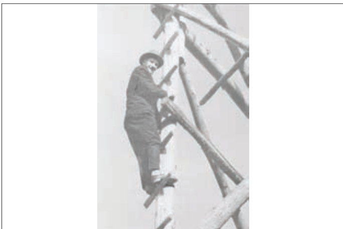
Ф.В.Лукин на реперном знак на месте будущего строительства РЛС дальнего обнаружения "Дунай-3" у деревни Акулово под Кубинкой
