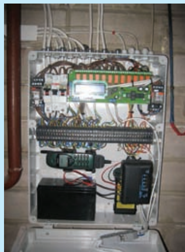
Рис.3. Блок управления с модулем NM8036 и GSM-сигнализацией
