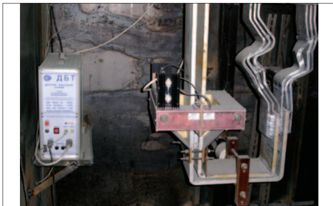
Рис. 6. Датчик больших токов ДБТ, смонтированный на токовой шине ванны электролиза алюминия
