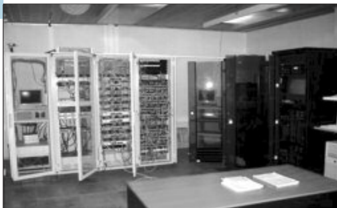
Рис. 1. Центральная кроссовая ЛВС Управления ЗФ ОАО ГМК "Норильский Никель"
