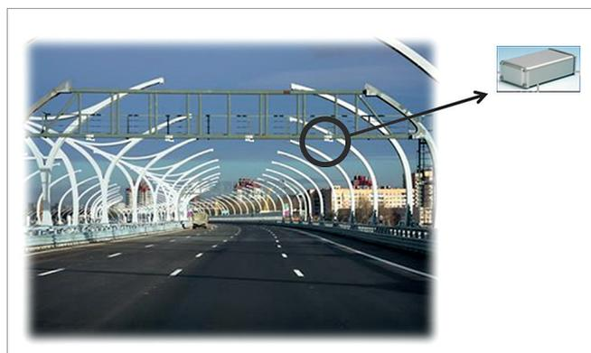
**Рис.7.** Пункт контроля с установленными считывателями РЧИД
