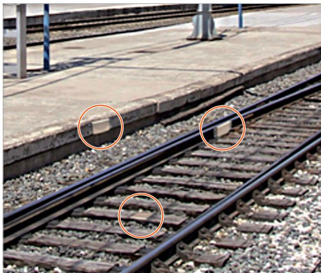
**Рис.3.** ПАВ-метки, устанавливаемые на железнодорожном полотне
