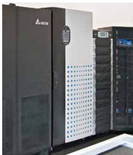
Шкаф бесперебойного питания
