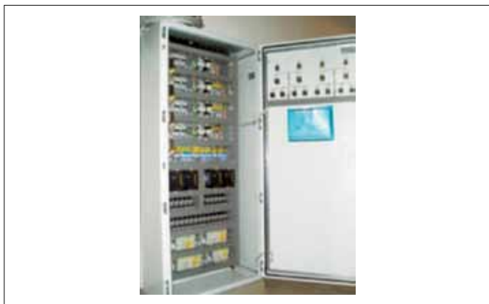
Рис.4. Пример использования источников питания Power-One в шкафу системы управления вентиляционной установкой здания [6]
