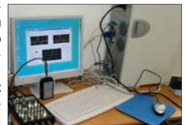
Рис. 2. Общий вид управляющего комплекса
