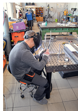
Сварка металлических конструкций
