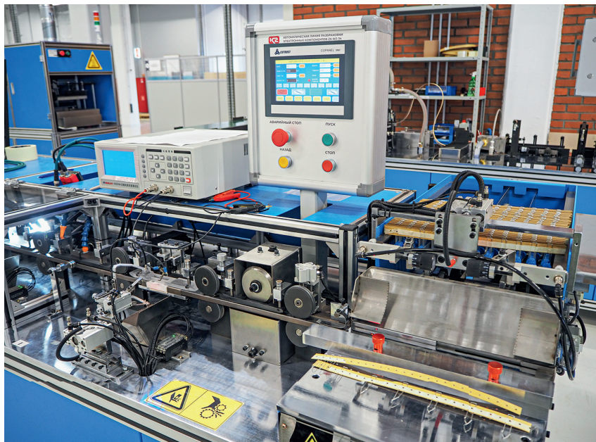
Блок обрезки перемычек контактных групп и автоматического контроля электрических параметров
