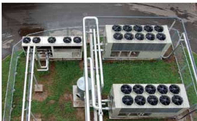
**Рис.5.** Чиллеры системы утилизации вторичного тепла
