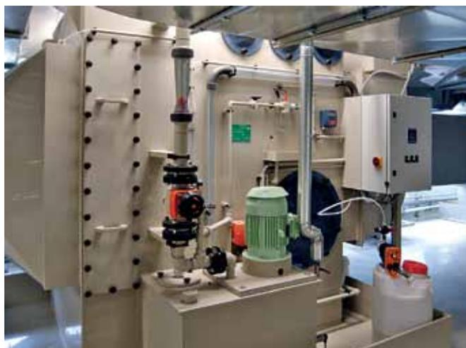
**Рис.8.** Скруббер системы нейтрализации газообразных выбросов
