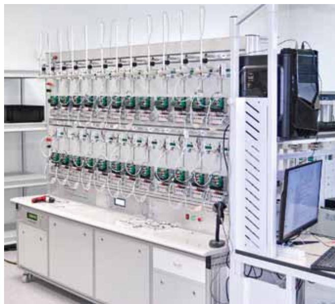
Стенд прогона приборов учета электроэнергии
