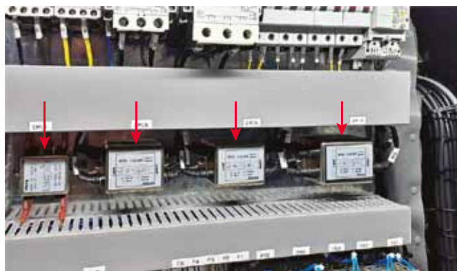
Рис. 10. Размещение фильтров электропитания (указаны стрелками) внутри автоматической зондовой станции
