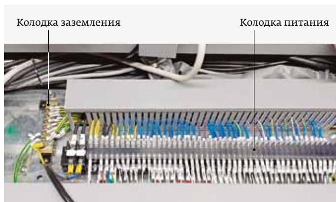
Рис. 11. Вывод всех проводов заземления и питания на единые клеммные колодки в автоматической зондовой станции
