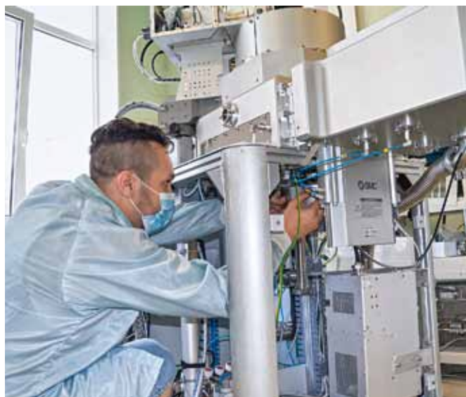
Монтаж установки плазмохимического травления STE ICP200E
