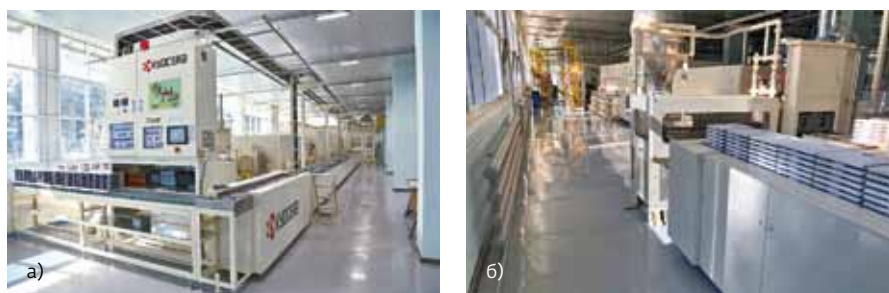
Рис. 5. Туннельная печь для спекания металлокерамических плат на территории АО «ЗПП»: а – общий вид; б – зона загрузки
