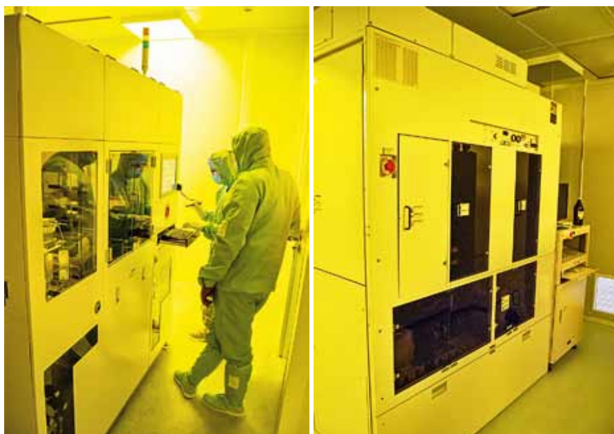
Введенные в эксплуатацию на новом участке установка нанесения и проявления фоторезиста (а) и система проекционной литографии (б) с размером запечатываемого кадра 44×44 мм
