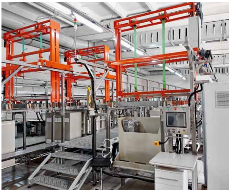
Оборудование в процессе пусконаладки
